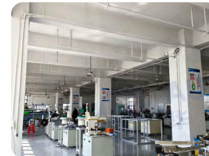
调试区域 Debugging area
